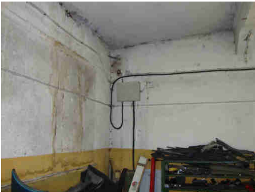
Foto 11. Siseneva maakaabliga elektrikilp hoone lääneküljel. Vt. ka hoone plaani ja Asendiskeemi AS-2
