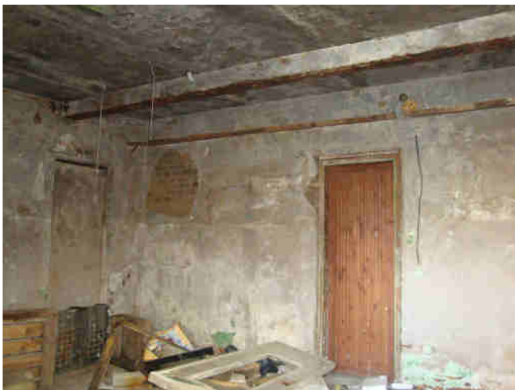
Foto 8. Hoone sisevaade. Hoonel tellisseinad, betoontaladega laed. Põrandal vedelev prügi.
