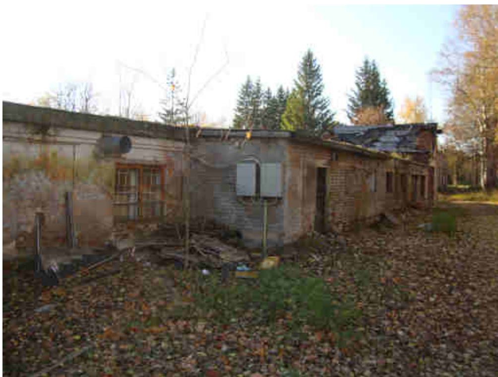
Foto 10. Siseneva maakaabliga elektrikilp hoone põhjaküljel. Vt. ka hoone plaani ja Asendiskeemi AS-2
