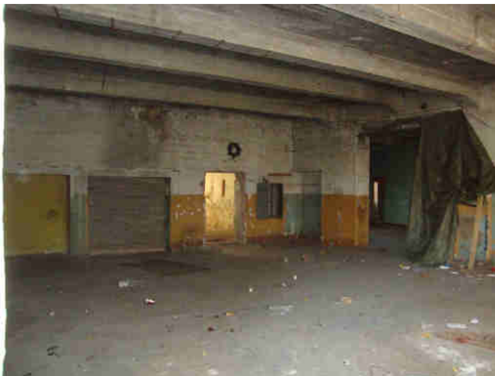
Foto 6. Hoone sisevaade. Hoonel tellisseinad, betoontaladega laed
