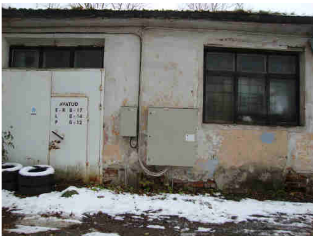
Foto 12. Jaotuskilbid hoone sisehoovis. Vt. ka hoone plaani ja Asendiskeemi AS-2.
